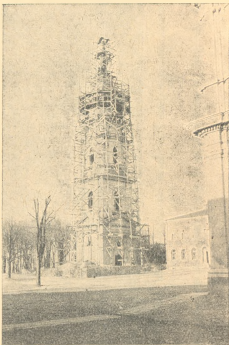
Dzwonnica w stanie przebudowy.
