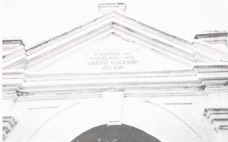
Tympanon z tablicą pamiątkową nad portalem wejściowym do budynku dawnego kolegium oo. pijarów w Lubieszowie – foto autor
